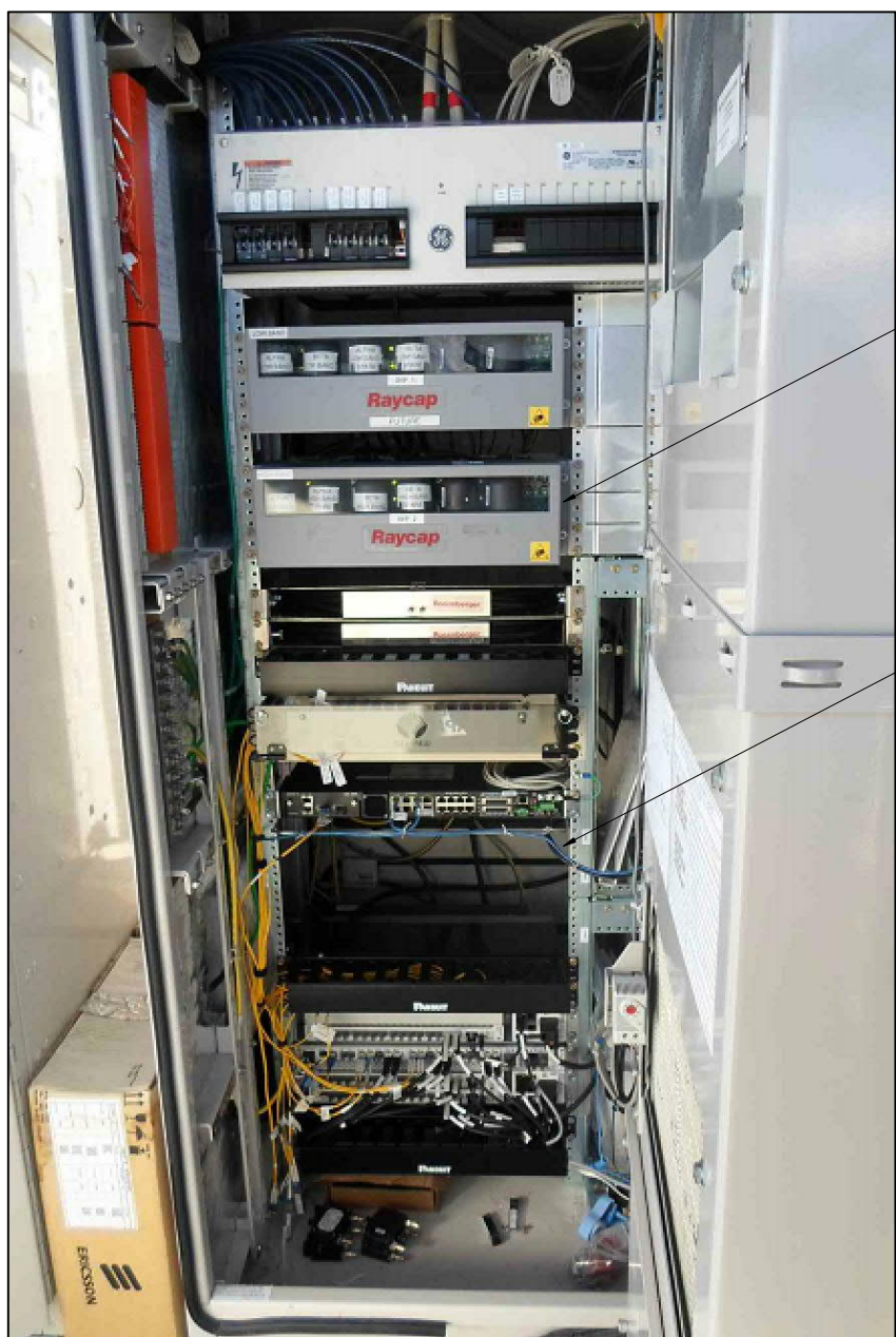
BBU CABINET DETAIL SCALE: N.T.S.
